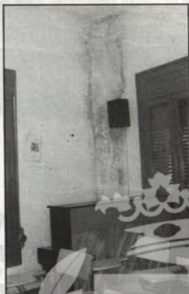
Las goteras son visibles. Esta es una de las aulas que tendrá que clausurarse este año.
