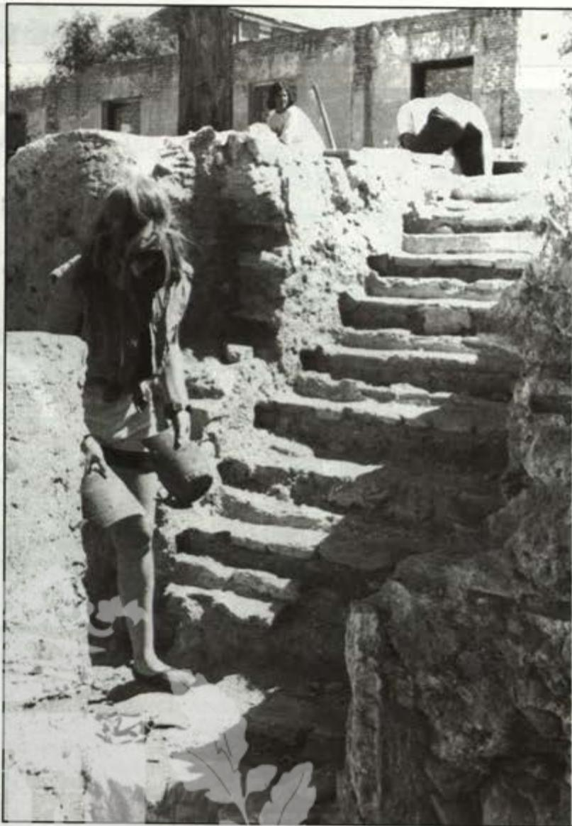
«Dédalo» de la excavación con un primer plano de un muro de tapial cuya información puede ser importantísima. A la derecha puede verse una de las escaleras que conducían al sótano, en la que se ven los huecos en los que encajaban las huellas de los peldaños.
