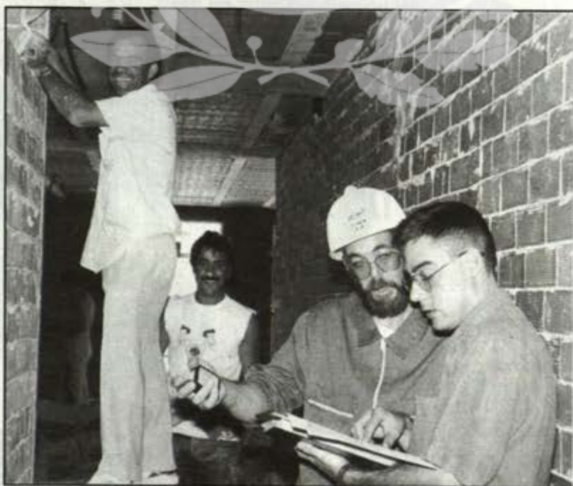
El concejal Jesús Domínguez Lazo supervisa las obras del nuevo centro cívico.
