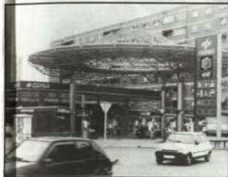
talar un museo de esculturas al aire libre y por nuestra parte hemos querido aportar un poco a ese museo con una nueva estructura adelantada a los tiempos en instalaciones de gasolineras. Totalmente garantizado por los ingenieros, lleva tubería de chapa galvanizada y la cúpula transparente es de plástico.
