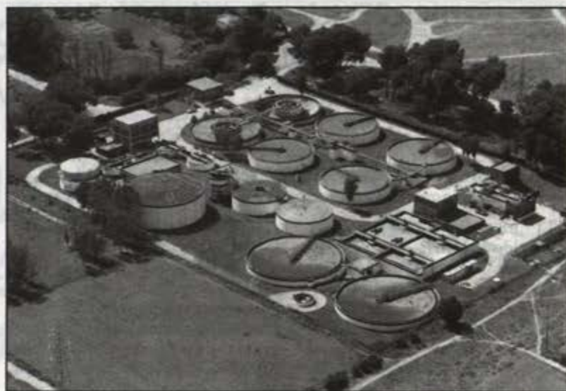
Depuradora de aguas urbanas
