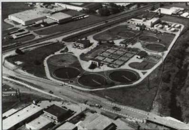
Depuradora de residuos industriales
