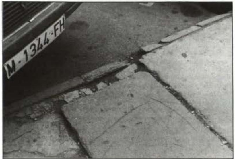
Cuando el vidrio no cabe en el contenedor, los usuarios lo depositan en el suelo y la acera de cemento se agrieta con el paso del tiempo.
