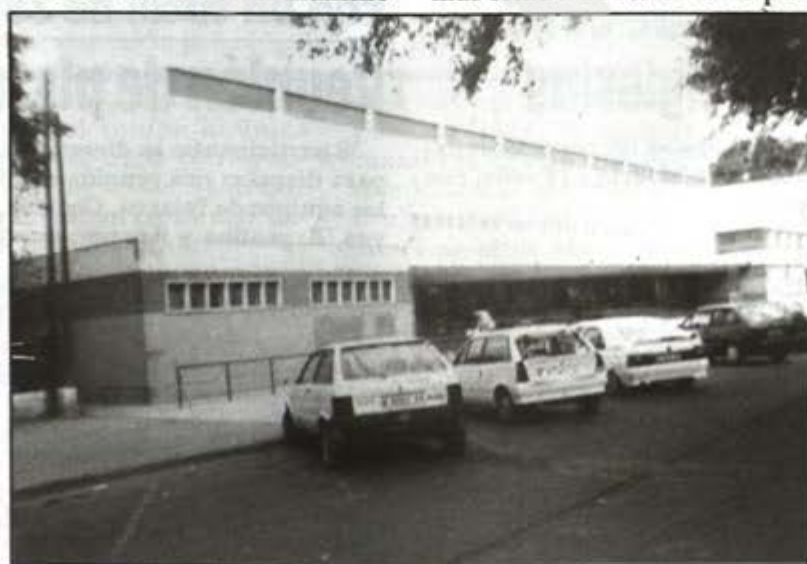
Pabellón polideportivo El Val
