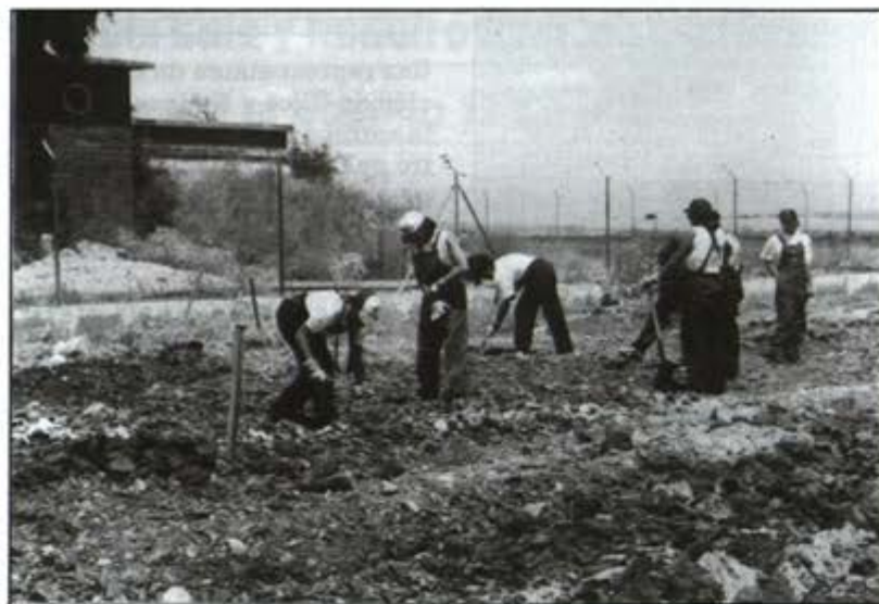
Realización de tareas de acondicionamiento del terreno
