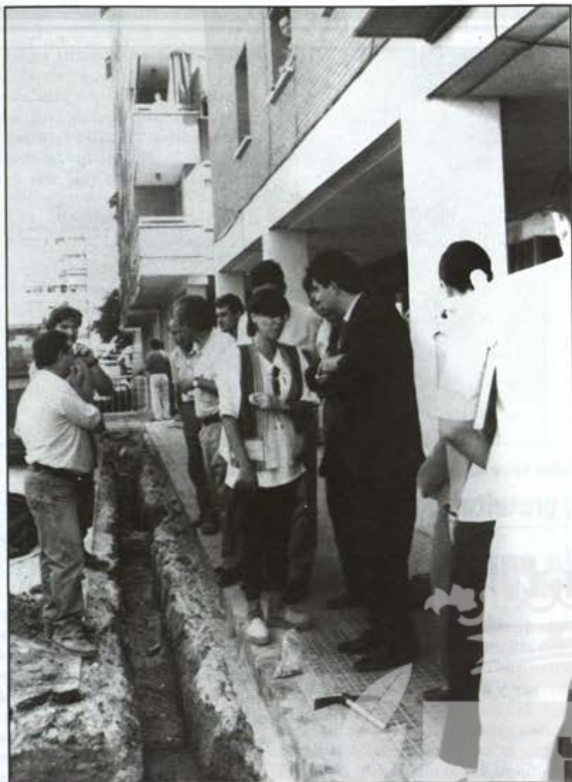
El alcalde, Bartolomé González, estuvo presente el viernes en los trabajos de prospección de la calle Diego de Torres.
