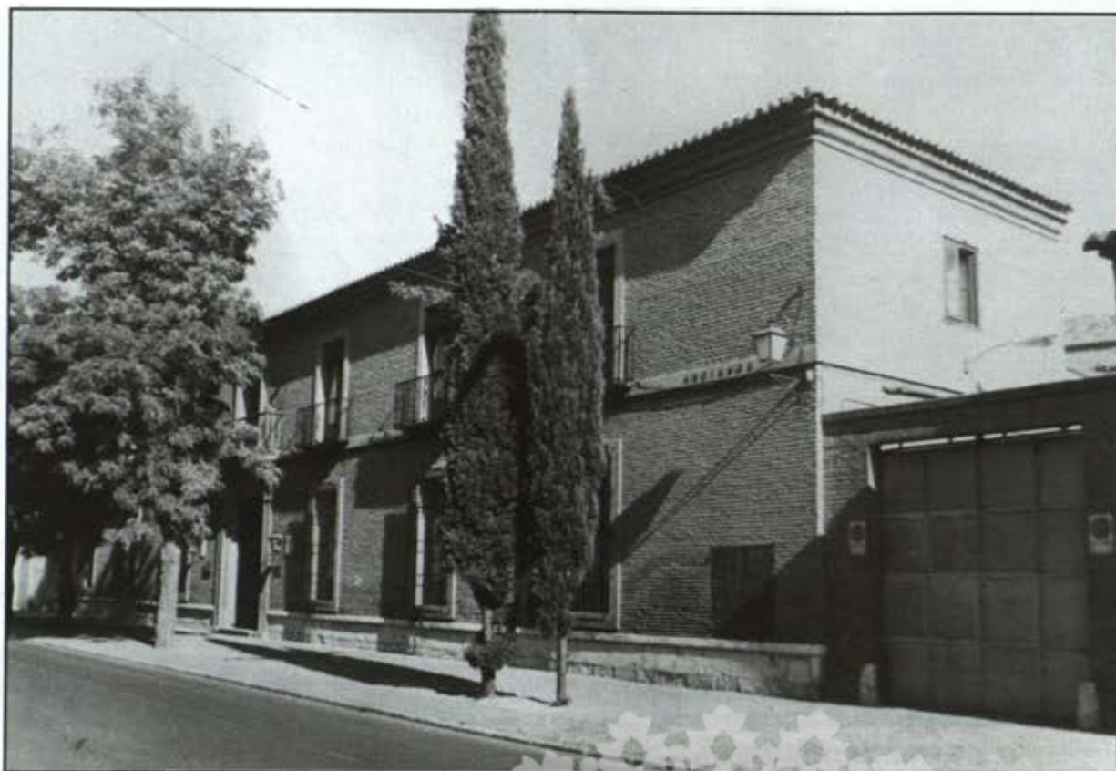
Edificio del antiguo asilo de ancianos del ayuntamiento de Madrid, al que el ayuntamiento de Alcalá quiere trasladar sus dependencias.
