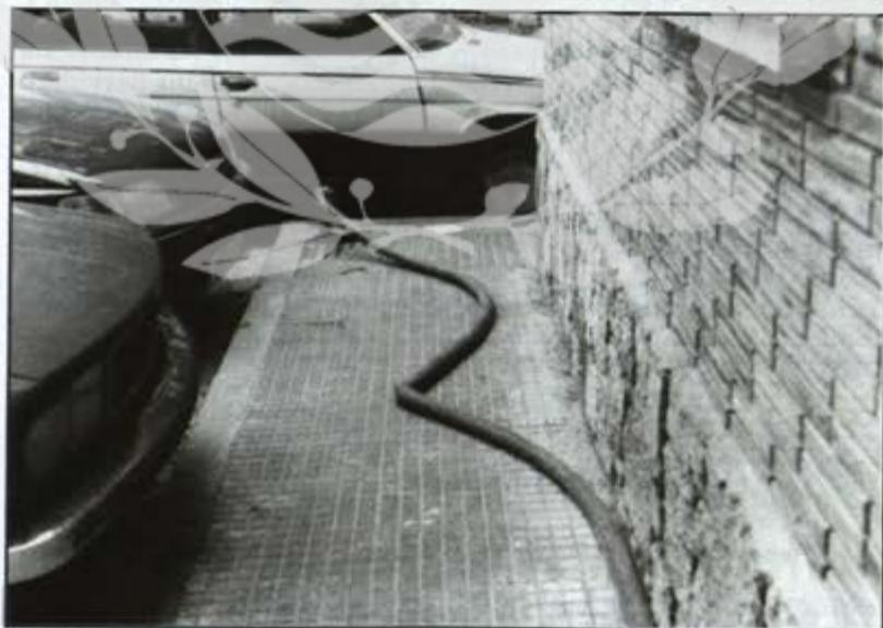
Los técnicos municipales han colocado esta manguera para extraer agua del fondo de saco de la red y enviarla a la alcantarilla, con el objetivo de suprimir el sospechoso encharcamiento en la tubería.
