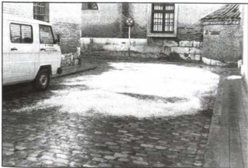
URBASER cubrió con serrín el gasoil para evitar deslizamientos.
