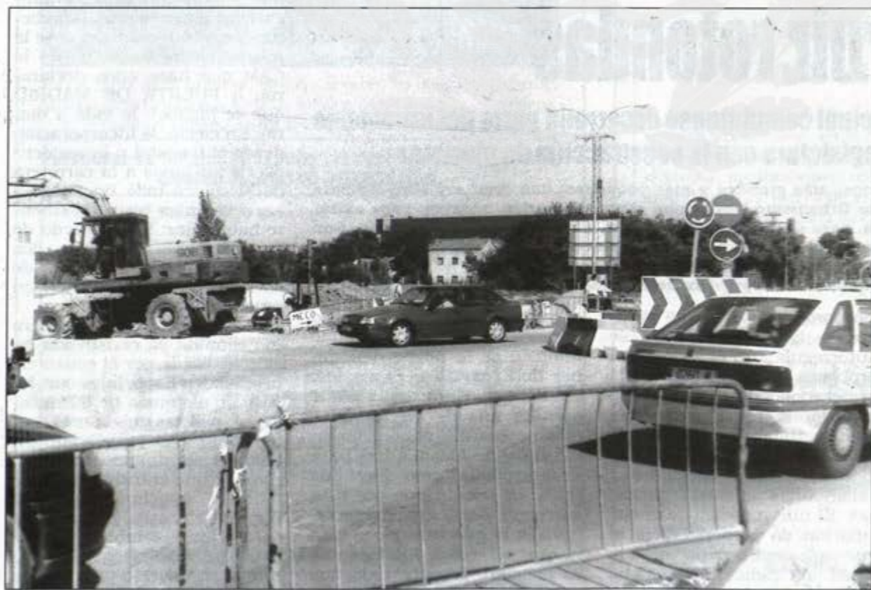
La rotonda de Los Nogales está en obras.
