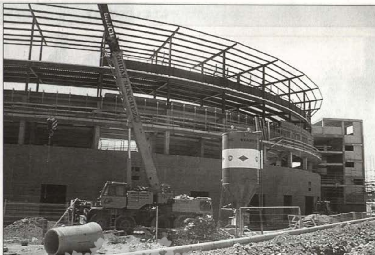
Así se encontraba la obra de la nueva plaza de toros el día 22 de agosto.
