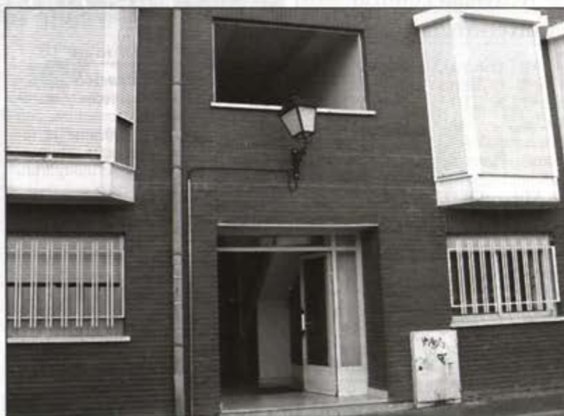
Entrada a la vivienda donde residía el fallecido. Como se puede apreciar en la fotografía, hubo que desmontar la ventana superior para aliviar el pestilente olor
