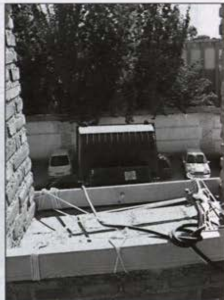
Este foco, situado en un torreón, está sujeto con cuerdas y los cables a mano de cualquier persona que pase por allí, por lo que supone un serio peligro de accidente
