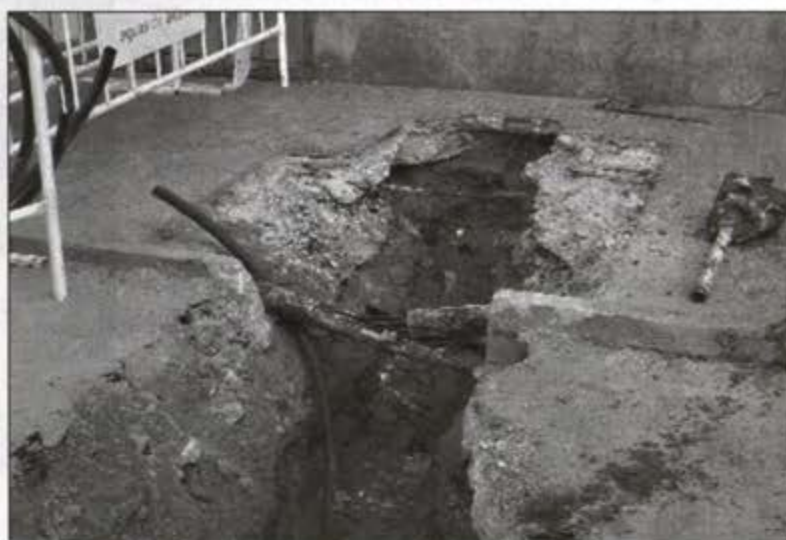
Obra realizada por el Parque de Servicios a las 0:00 del 9/09/04 para poder restablecer el fluido eléctrico que afectaba al alumbrado público de varias calles aledañas. A la derecha, avería ocasionada en el alumbrado público
