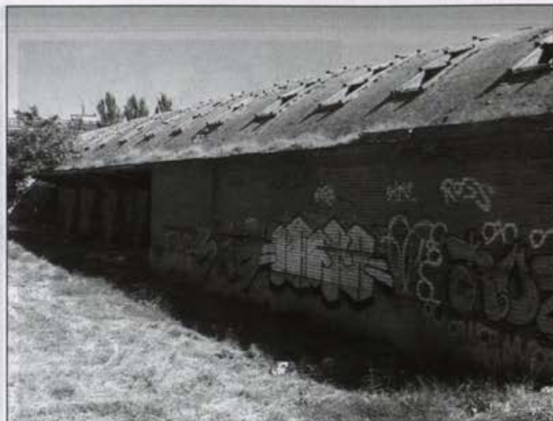
Restos de una nave industrial de la antigua Forjas de Alcalá.
