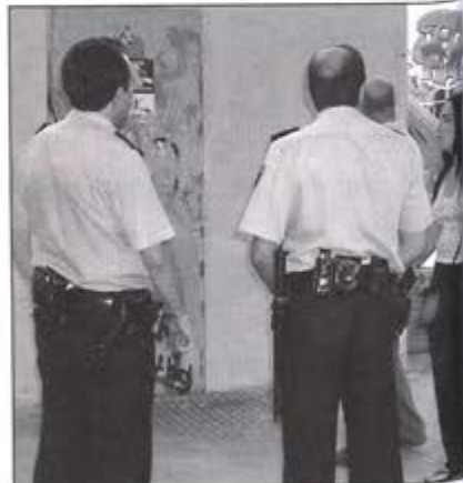
El transformador estuvo vigilado por la Policía Local.
