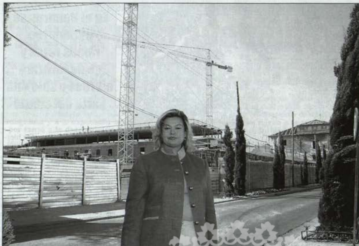
La concejala de Turismo, Marta Viñuelas, junto a las obras del futuro parador
