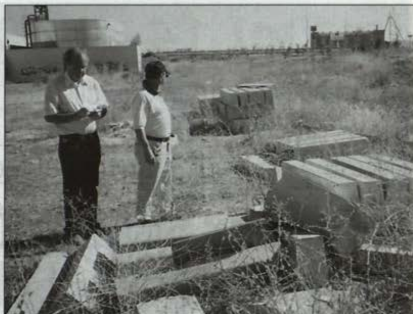
Bordillos de aceras tirados.
