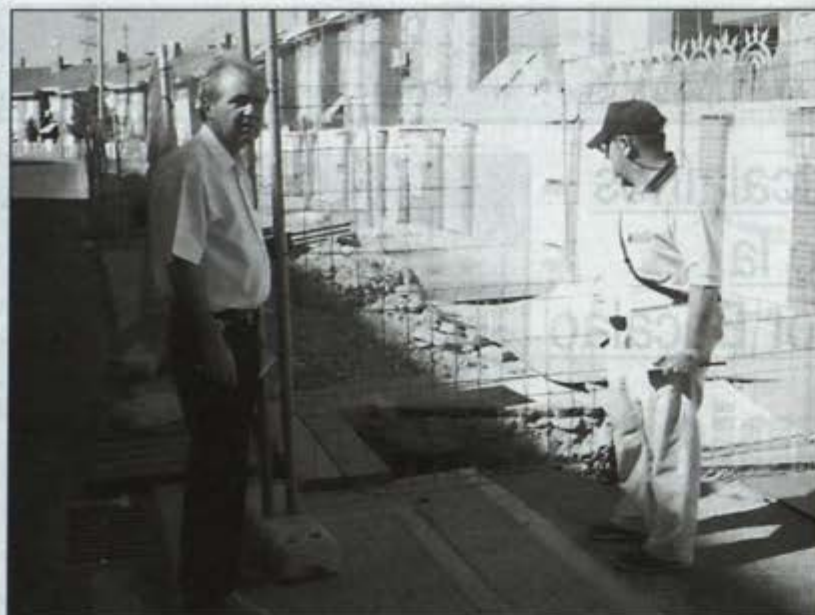
Obras en la calle Valle Inclán.
