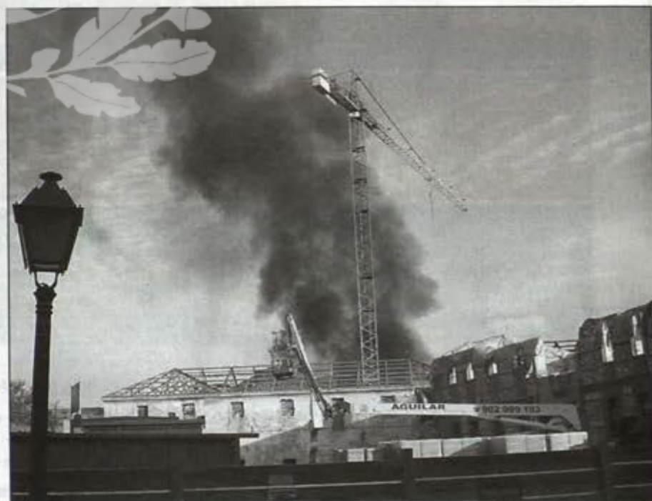
El incendio ocurrió al pie de esta gran grúa y hubo quien creyó que había cierto peligro de que se derrumbara.
