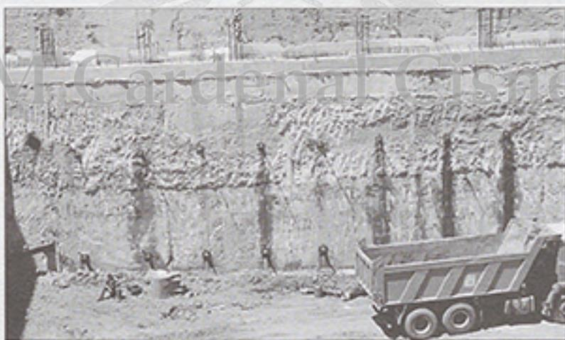
Ha sido necesario construir muros pantalla para contener la capa freática para evitar la emanación de agua del subsuelo
