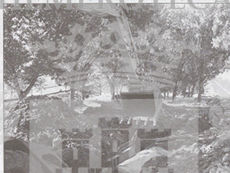
del casco urbano. Una vez terminadas las obras, el arroyo recogerá las aguas pluviales procedentes de los sectores R-1 y R-2. Las actuaciones en el cauce consistirán en dos tipos diferentes de adecuaciones. La primera de ellas consistirá en el soterramiento de un tramo del cauce que tendrá una longitud de 398 metros, entre la cota 692.20 metros, en la captación del Arroyo de Valdeserrano, y hasta la cota de los 684.52 metros en el entronque de Valdeserrano con el Arroyo de las Monjas.
