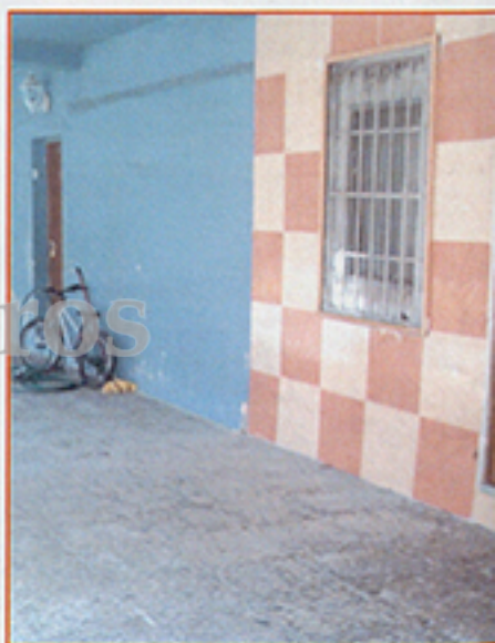
Los ocupantes ilegales han modificado los locales comerciales pintando sus fachadas sin atenerse a ningún tipo de normativa.
