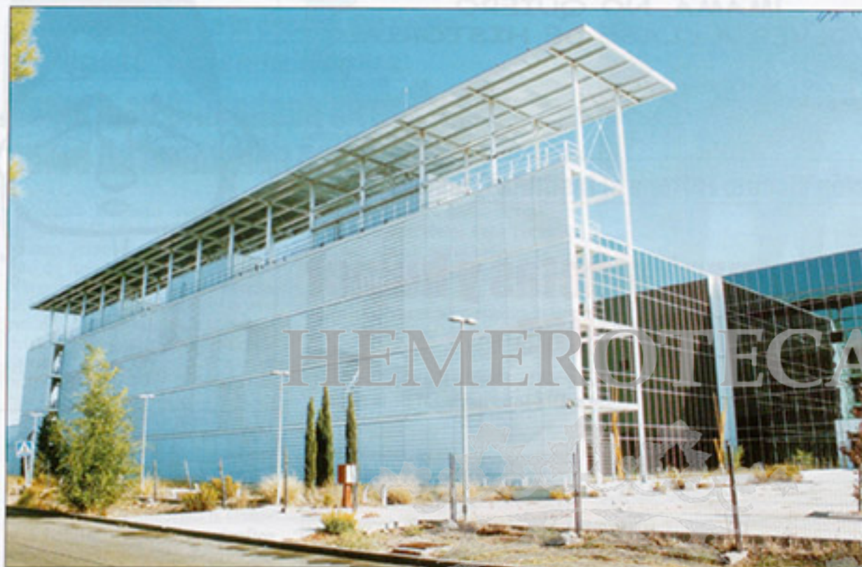
El edificio que iba a ser la sede del IMMPA tampoco lo será de la AEM.
