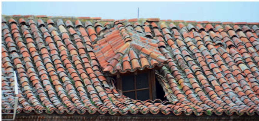
Cubierta de la Casa de la Entrevista, antes de la intervención.
