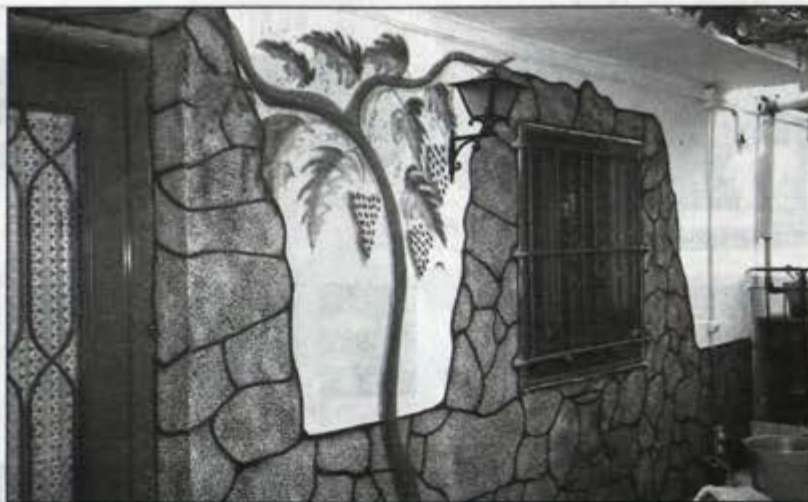
Decora las fachadas de las casas situadas en la finca "El Practicante"
