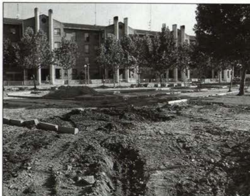
La plaza de Sepúlveda se encuentra en obras.
