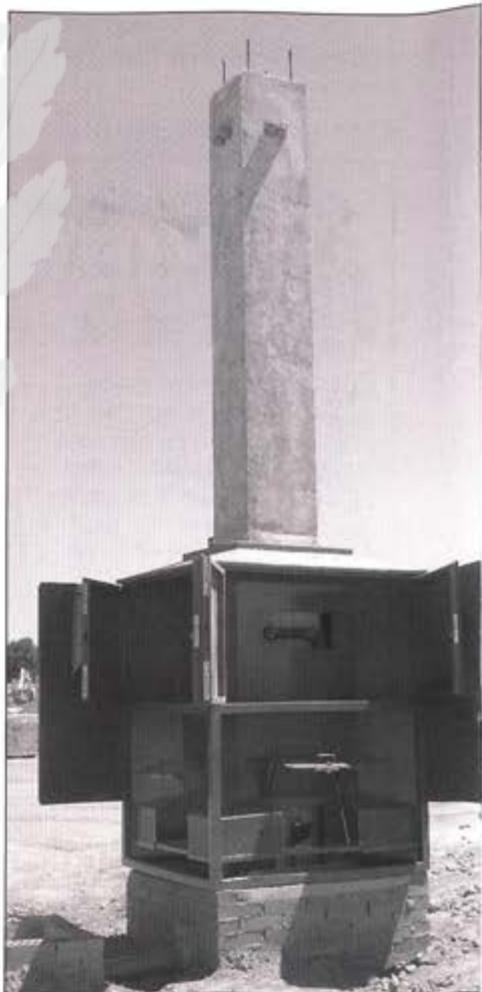
A la izquierda, un aspecto del caz, que se mantiene totalmente seco durante las obras. Sobre estas líneas, las columnas en las que serán instaladas las farolas llevan integrados todos los servicios: tomas de electricidad, tomas de agua y desagües.
