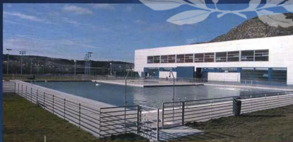
Nuevas instalaciones deportivas
