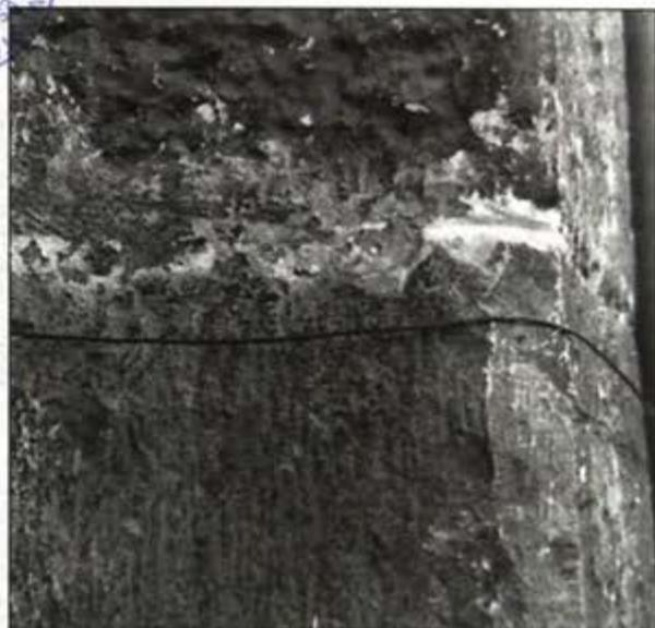
Sobre estas líneas se puede apreciar un detalle de las estrías que los alambres han causado en la piedra de las columnas de los soportales de la calle Mayor.
