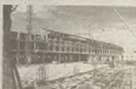
FOTO: Marzo '96. Albarilería en fachada posterior a Cta. de Pastrana.
