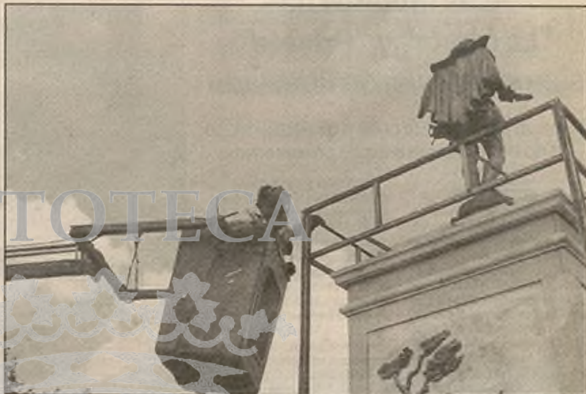
Un operario del Ayuntamiento instalando la estructura metálica alrededor de la estatua de Miguel de Cervantes
