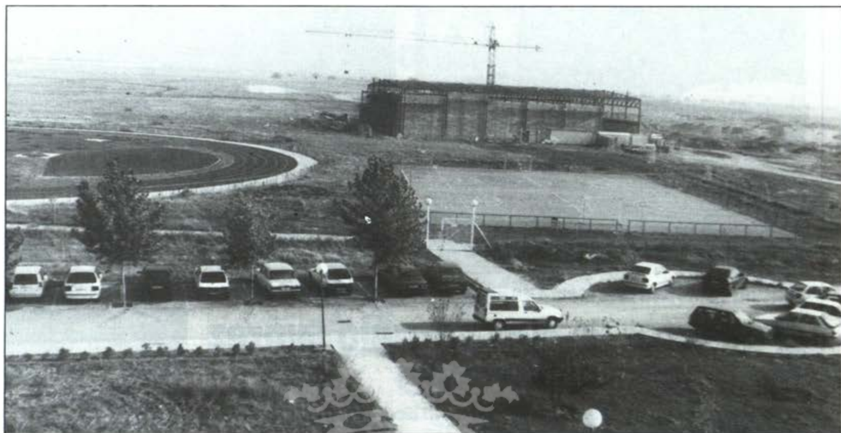
He aquí las instalaciones deportivas que actualmente hay en el campus, con la pista de atletismo y las polideportivas. Al fondo, las obras de construcción del polideportivo cubierto.
