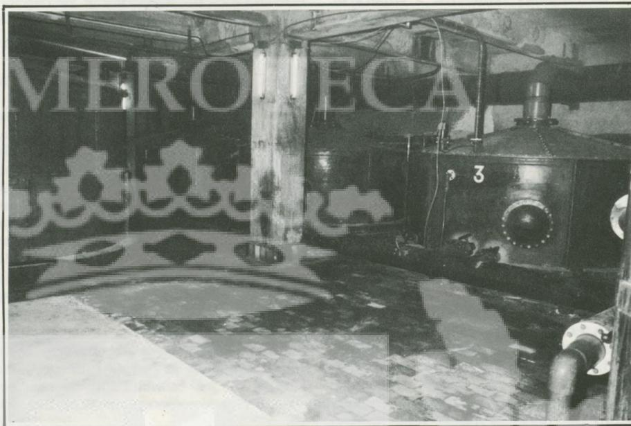
*Se trataba de sustituir los viejos depósitos de hormigón por otros nuevos, de fibra de vidrio-poliéster, tapados, con colectores de idéntico material.*
