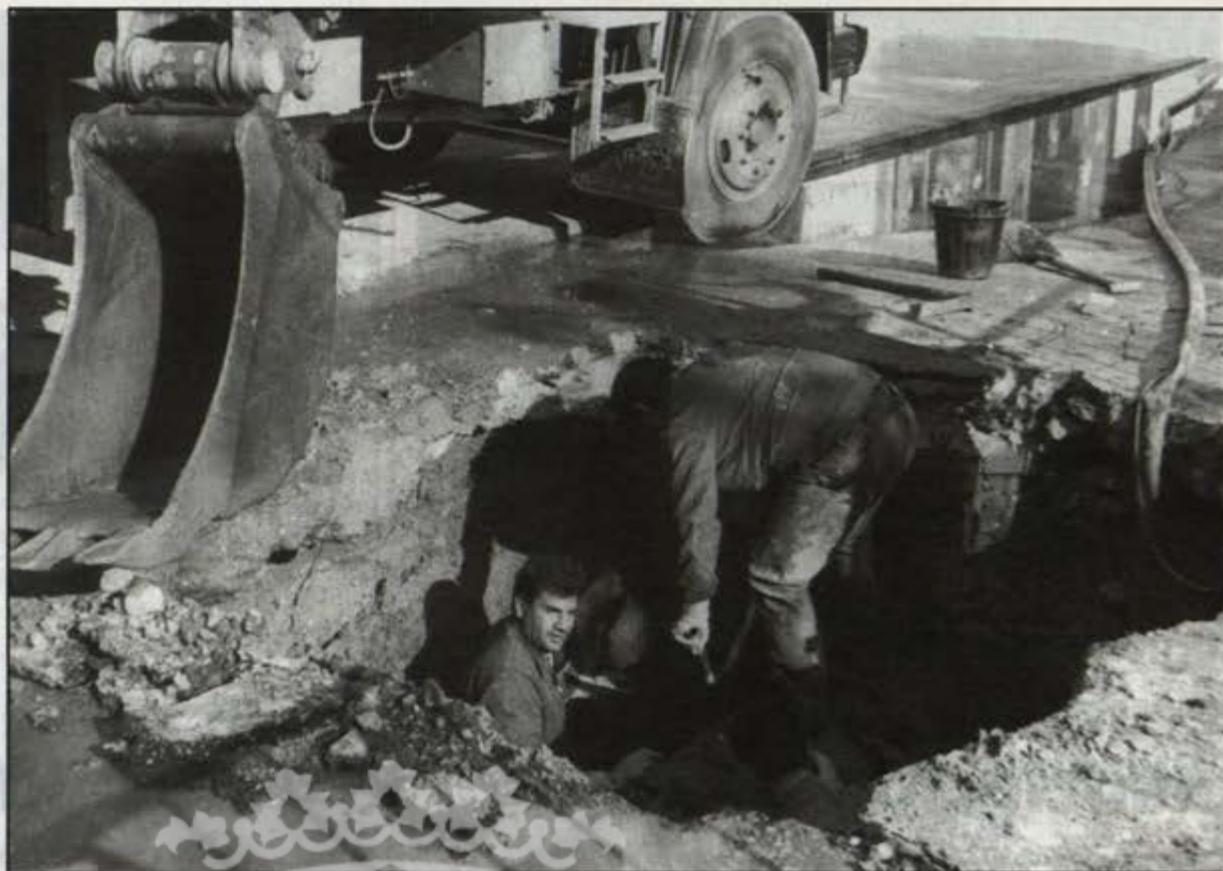
te, ya que se trataba de un reventón que ha habido en la red, en la tubería general, causado por una sobrecarga».
