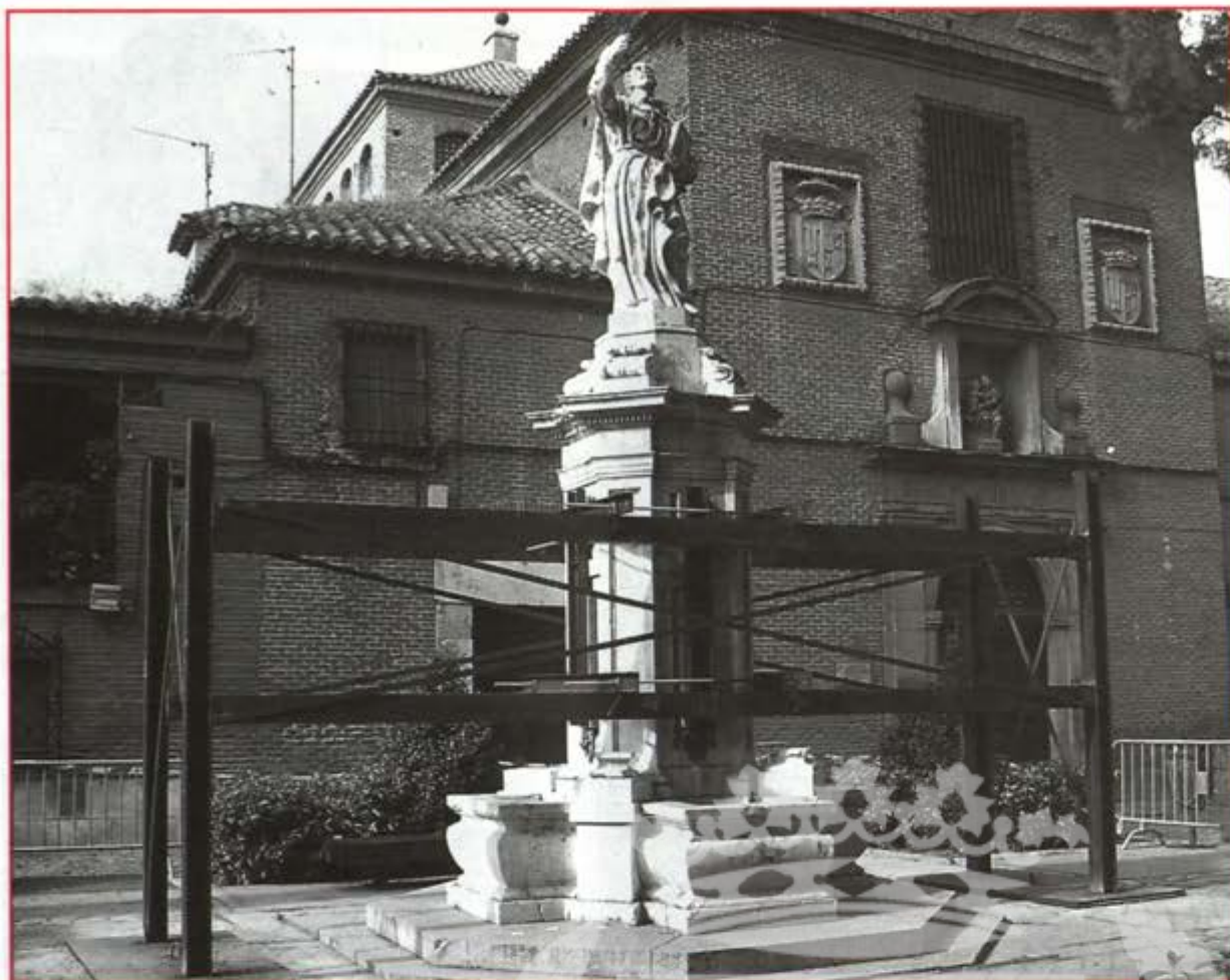
Apeo del conjunto para empezar las obras en la plaza de los Doctrinos
