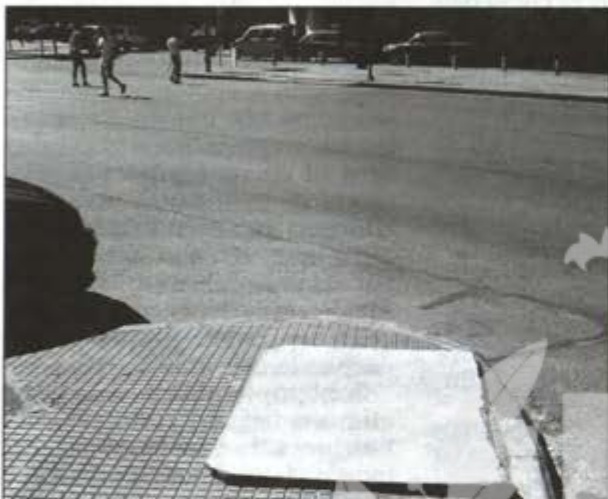
Via Complutense, esquina C/Diego de Torres.
